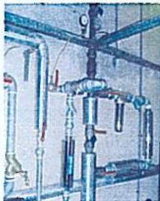
Ensemble New Ionic en chauffe-eau.
