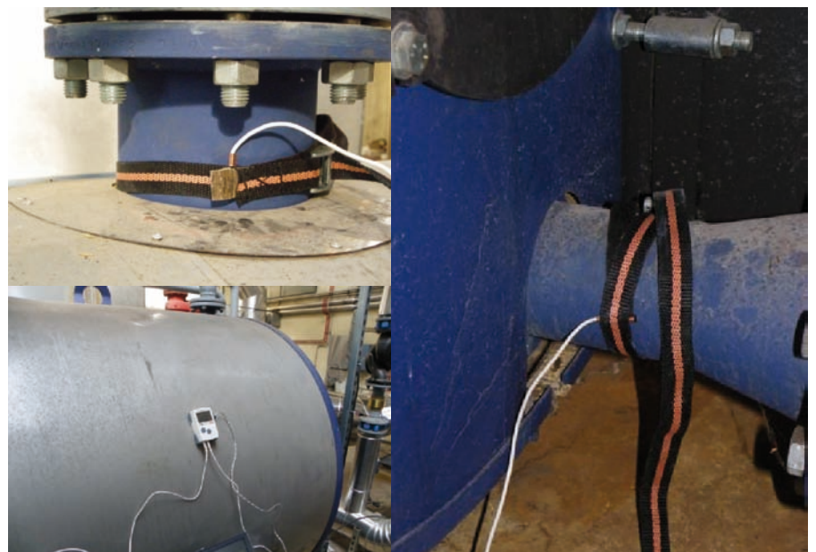
Pose des capteurs départ/retour eau de chaudière Raccordement au boîtier d'enregistrement.
